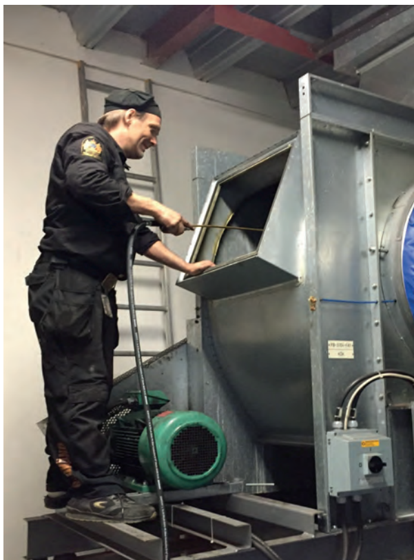
Rensningsarbete utförs av vår skorstensfejartekniker, Foto: NÄRF
